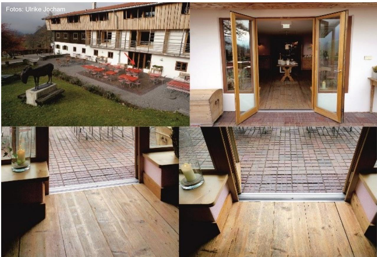
Doch derartige technische Gründe gibt es für 1 - 2 cm hohe Türanschlagdichtungen bei Hauseingängen und bei Terrassen- und Balkontüren insbesondere im Neubau seit über 2 Jahrzehnten nicht mehr. Zahlreiche Einbaubeispiele belegen, dass die Technik der Magnet-Nullschwelle selbst nach über 20 Jahren immer noch systemsicher und nachhaltig abdichtet. [9]
